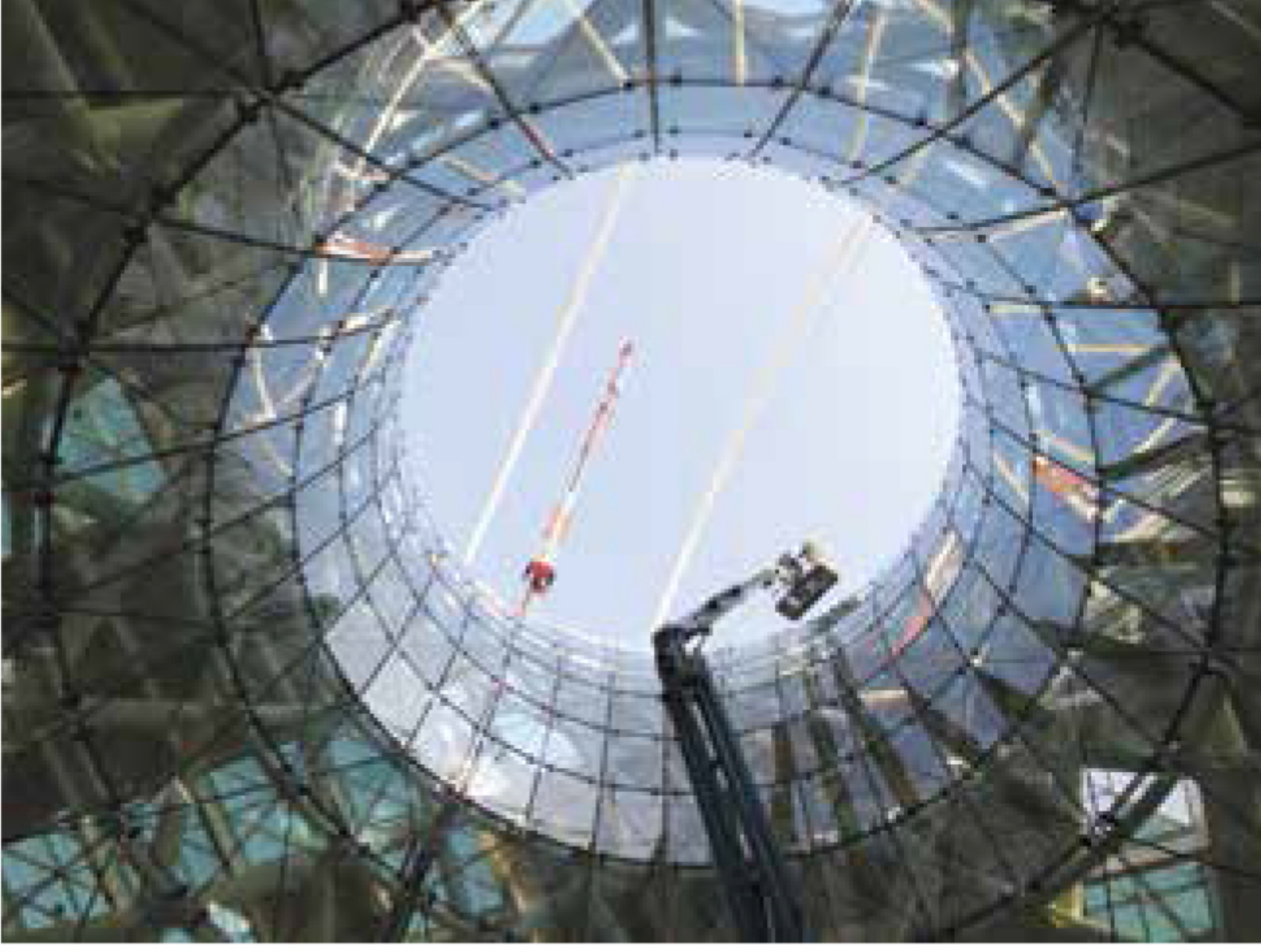
Fil Ayağı yapım aşaması
