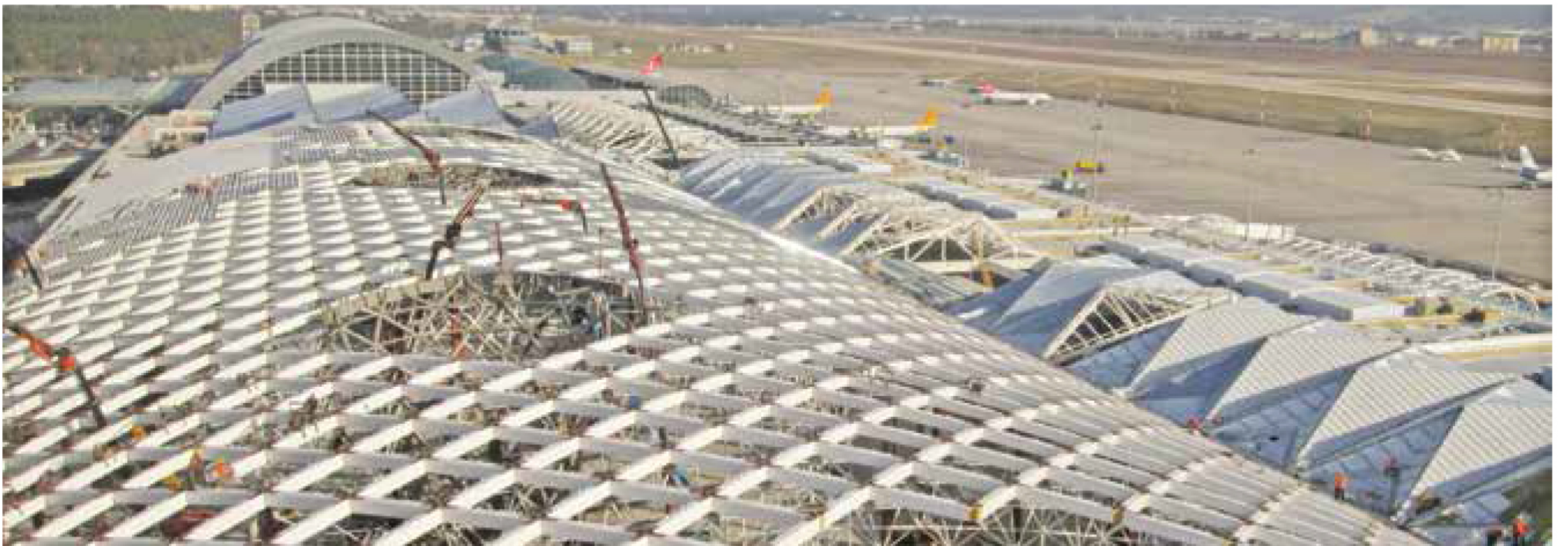
Tonoz Çatı yapım aşaması
